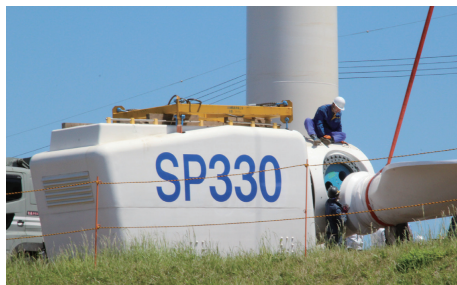
地上に置いたナセルでブレードの取り付け作業が行われる。
