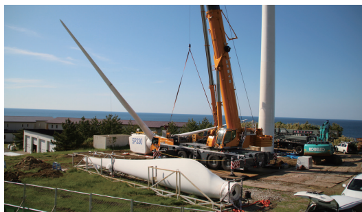
中型風車のブレードを取り付ける様子。
